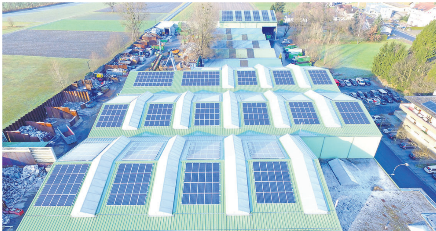
Die Solaranlage auf dem Dach des Recyclingcenters Elkuch Josef AG in Eschen ist die grösste an einem Messpunkt angeschlossene Fotovoltaik-Anlage in Liechtenstein. Jährlich werden circa 240 000 kWh an erneuerbarer Energie für den Eigengebrauch der Firma produziert. Umgerechnet könnten damit circa 50 Einfamilienhäuser versorgt werden. (Foto: IKR)
